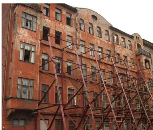
Рис. 3. – Фотофиксация консольной системы удержания фасада [9]
