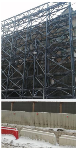
Рис. 2. – Фотофиксация вертикальной системы удержания фасада [авторское фото]
