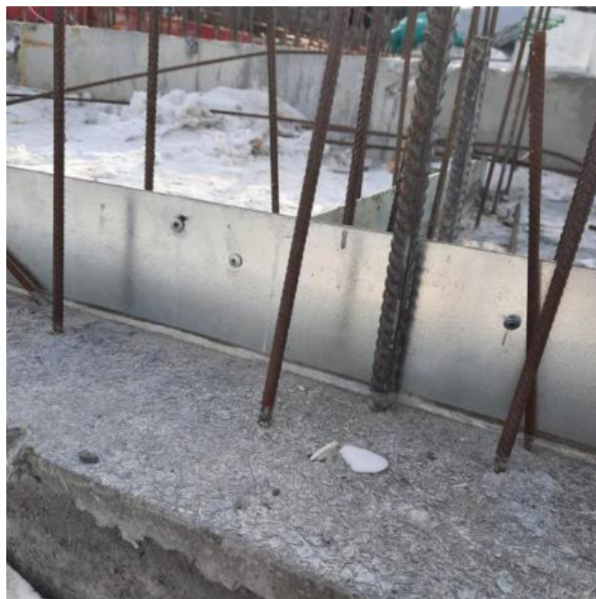
Рис.2. - Применение оцинкованного стального листа в качестве гидрошпонки на объекте в г. Екатеринбурге
