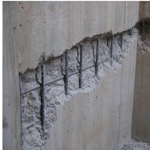
Рис. 3. – Отслоение бетона
