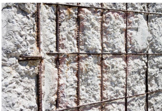
Рис. 1. – Коррозия арматуры
