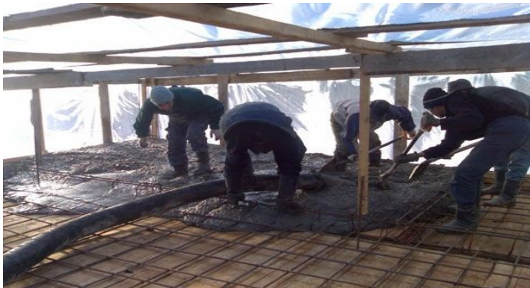
Рисунок 1. Зимнее бетонирование: тепляк, экранированный полиэтиленом.
