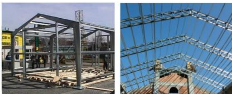
Рис. 1. – Применение элементов легких стальных тонкостенных конструкций [16],[17]
