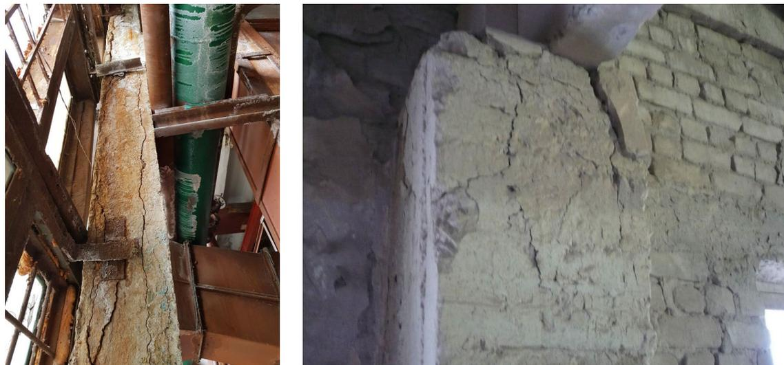
Рис. 2. – Трещины в теле бетона, некачественное усиление, незавершенное усиление
