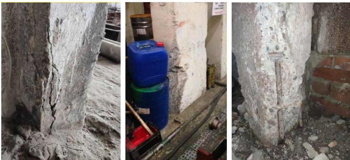
Рис. 1. – Трещины вдоль арматуры (слева) и сколы бетона в защитном слое бетона вдоль рабочей арматуры (центр и справа)
