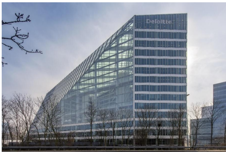
Рис. 2. – Офисное здание The Edge, Амстердам [7].
