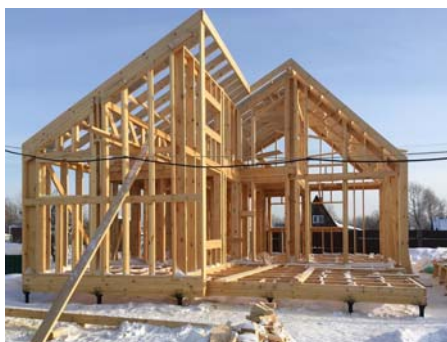
Рис.- 12. Слева на фото деревянный каркас на основании
