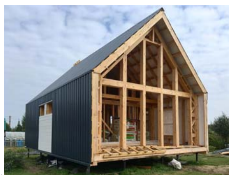
Рис.- 12. Слева на фото деревянный каркас на основании
