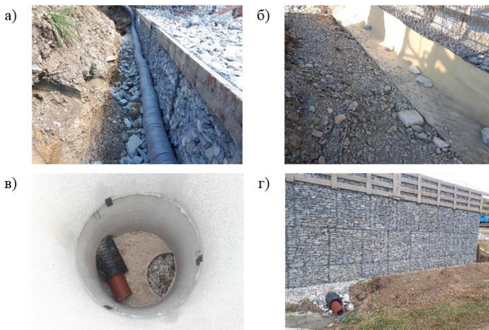
Рис. 3. – Технология укладки дренажной трубы:
