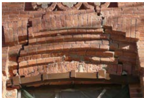
Рис. 3. – Разрушенные оконные проемы с более пологой формой, укрепленный металлическим каркасом (а) и без металлического каркаса (б)
