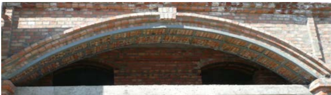
Рис. 2. – Оконный проем с пологой формой и большой шириной, укрепленный металлическим каркасом
